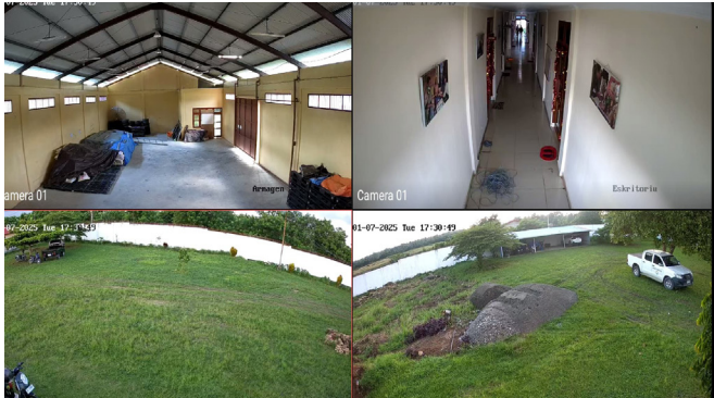
Resultado hosi instalasaun CCTV iha Armazem Bebora no iha edifisiu MSSSI Inklusaun (CSSI) Munisipiu Aileu no Viqueque
