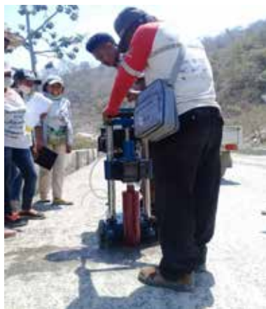
Técnicos da ADN realizam teste "profiling" no projeto da estrada Manatutu.
