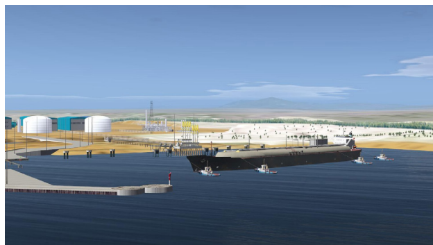
Instalações marítimas para o projeto TLNG
